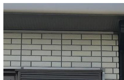
▲After (磁器タイル外壁)
