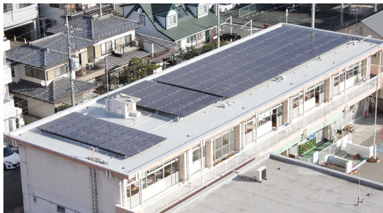
前橋市立第三保育所に設置した太陽光パネル
