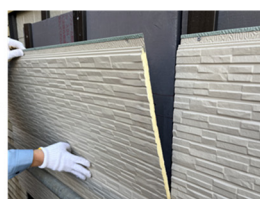
ガルバリウム鋼板(仕上げ材)を取り付け
