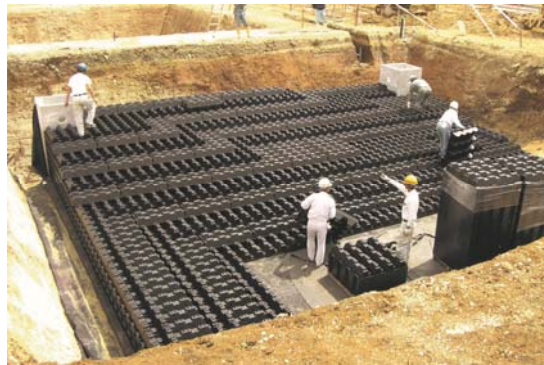
▼ クロスウェーブ設置の様子
