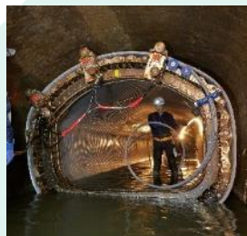
下水道管路更生
