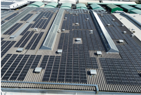
積水化学工業 群馬工場
