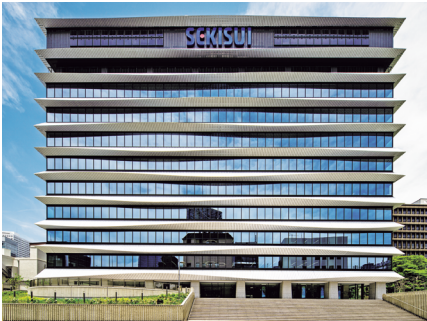
リニューアルが完了した大阪本社
